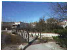
Pasarela sobre el cauce de la Rambla
