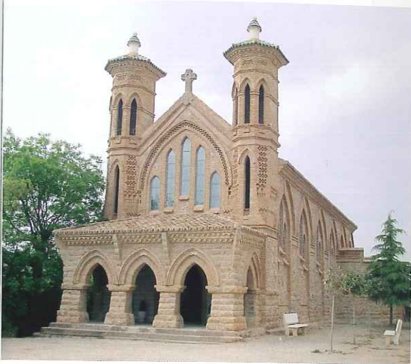
Iglesia del Salvador de Villaspesa
