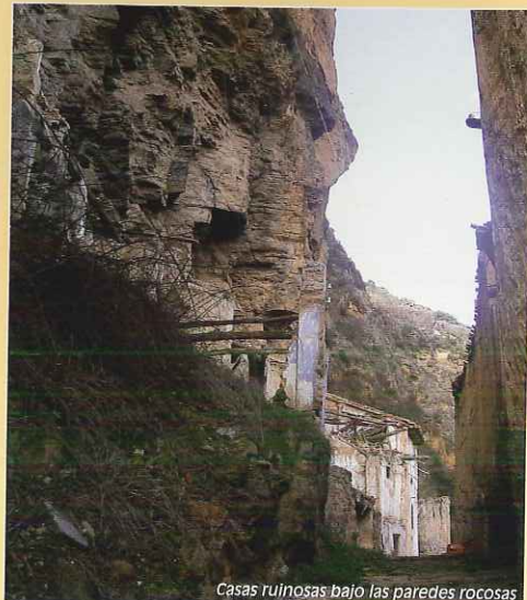
Casas ruinosas bajo las paredes rocosas
