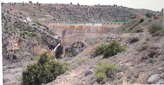
Presa del Embalse del Arquillo
