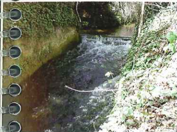
Zona en la que se separa el agua de la acequia de la Peña de la Guadalaviar
